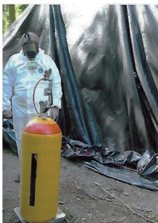
Obrázek 5. Asanace skládky fumigací ED
